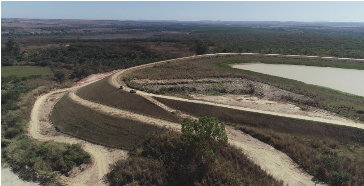
Figura 3: vista área da Barragem Cava B e região a jusante da estrutura.
