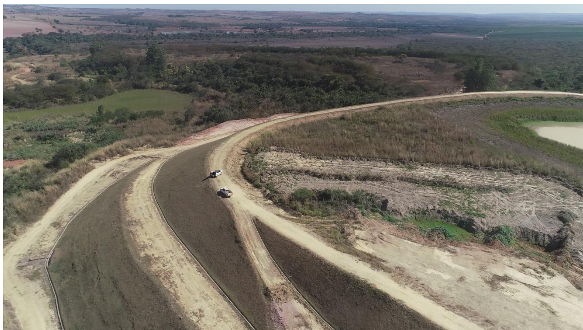
Figura 3: vista área da Barragem Cava B e região a jusante da estrutura.
