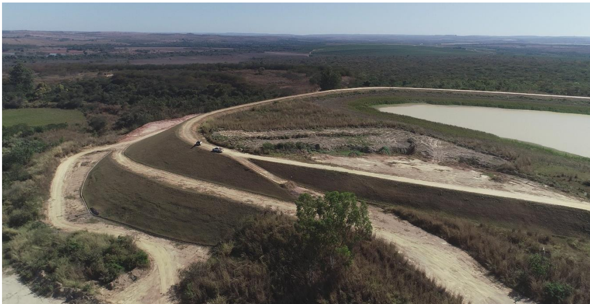
Figura 3: vista área da Barragem Cava B e região a jusante da estrutura.
