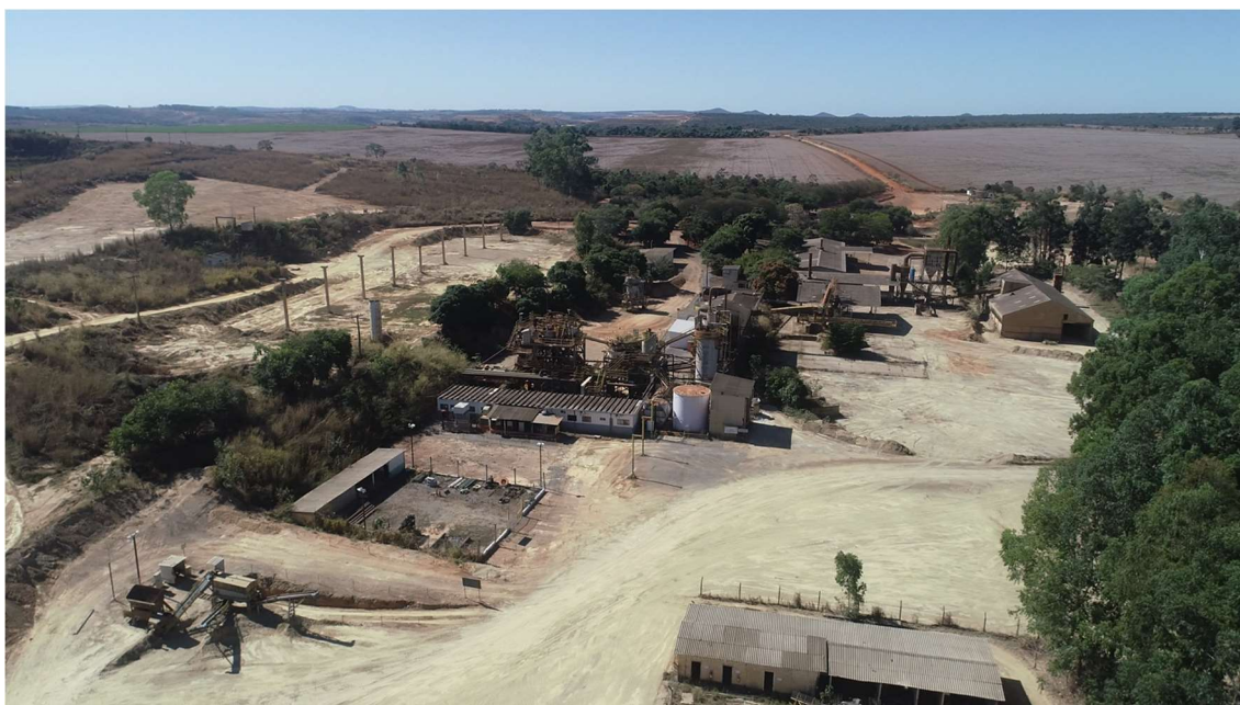
Figura 18: Vista geral do contexto do uso e ocupação do solo na área de influência da Barragem Cava B. Destaque para a área industrial e administrativa concernida fora da mancha de inundação.
