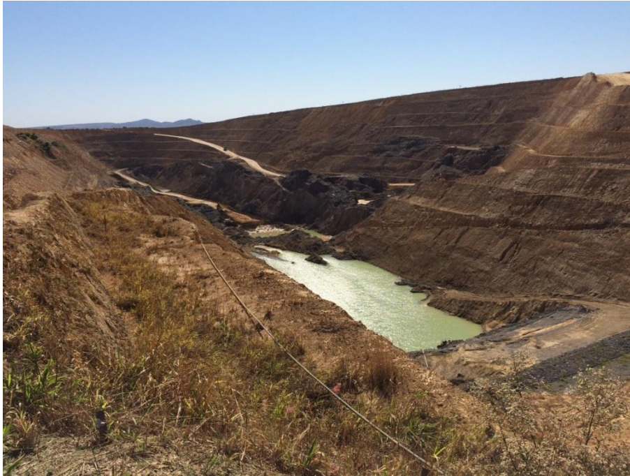
Foto 3.1-11 - Vista geral da Cava 2.
