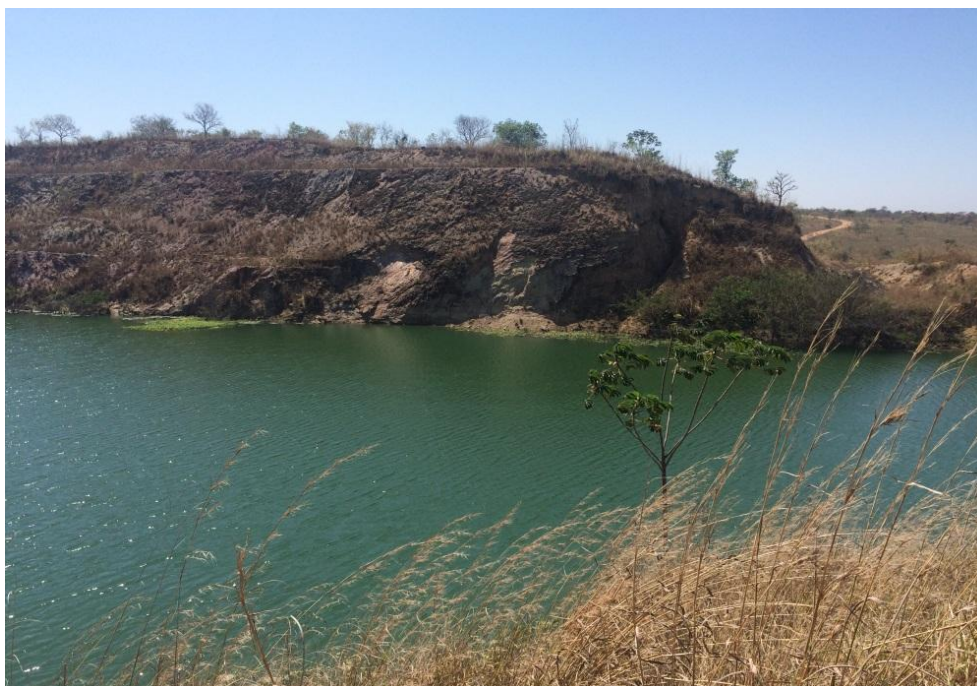
Foto 3.1-2 - Vista do talude em que ocorre instabilidade geotécnica.
