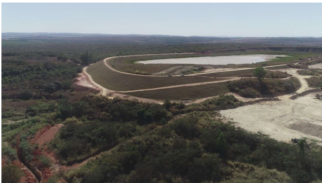
Figura 6: Vista geral da Barragem Cava B.
