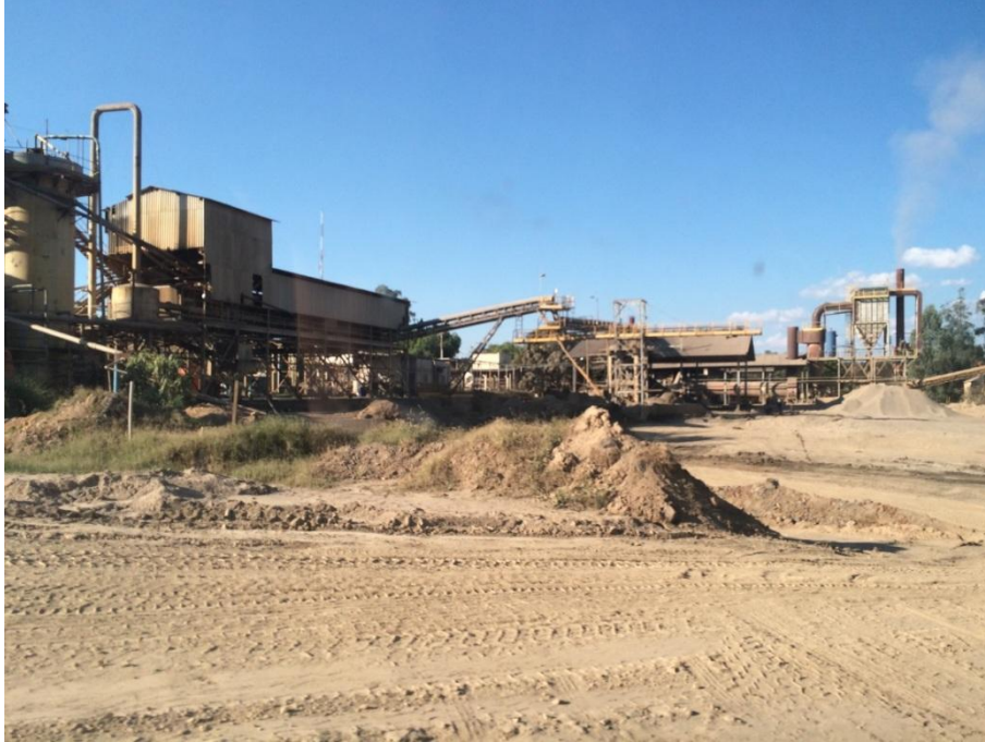
Foto 1.2-3 - Vista parcial das estruturas da ITM.
