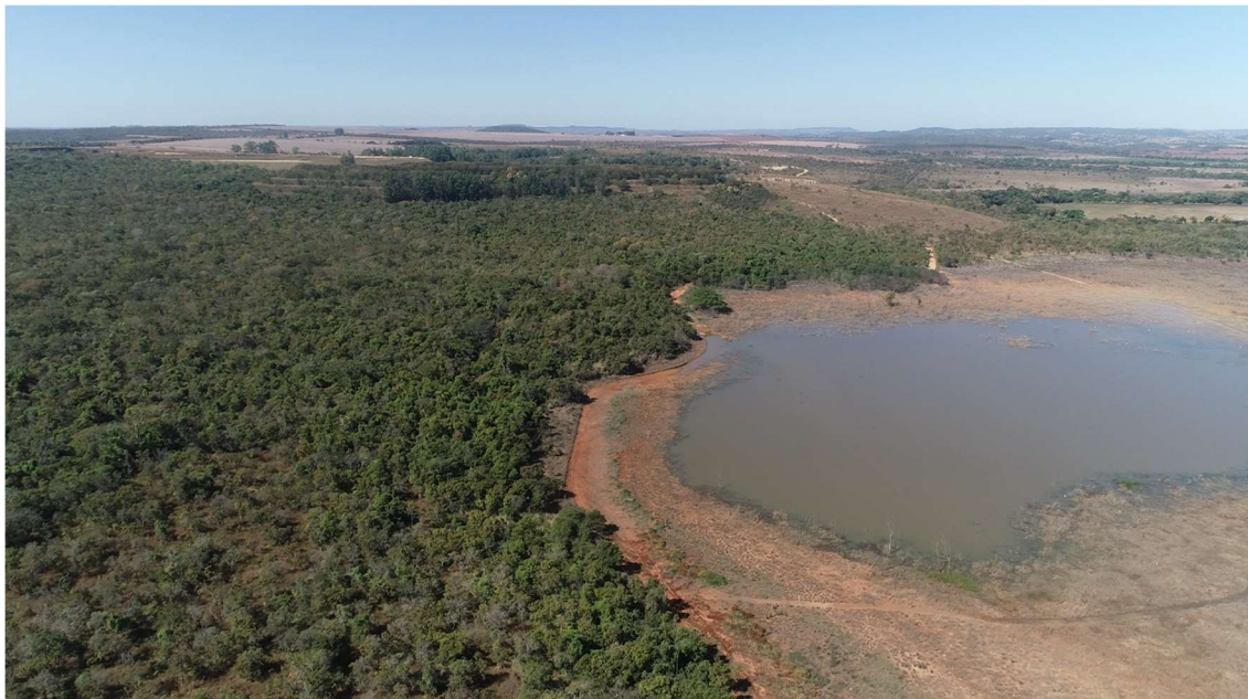
Figura 13: Vista geral do contexto do uso e ocupação do solo na área de influência da Barragem Cava B. Destaque para a lagoa natural, a jusante do barramento, para a qual não se verifica o alcance da mancha de inundação, conforme o Estudo de Ruptura Hipotética (12222-S-BA-RL-01-DB).
