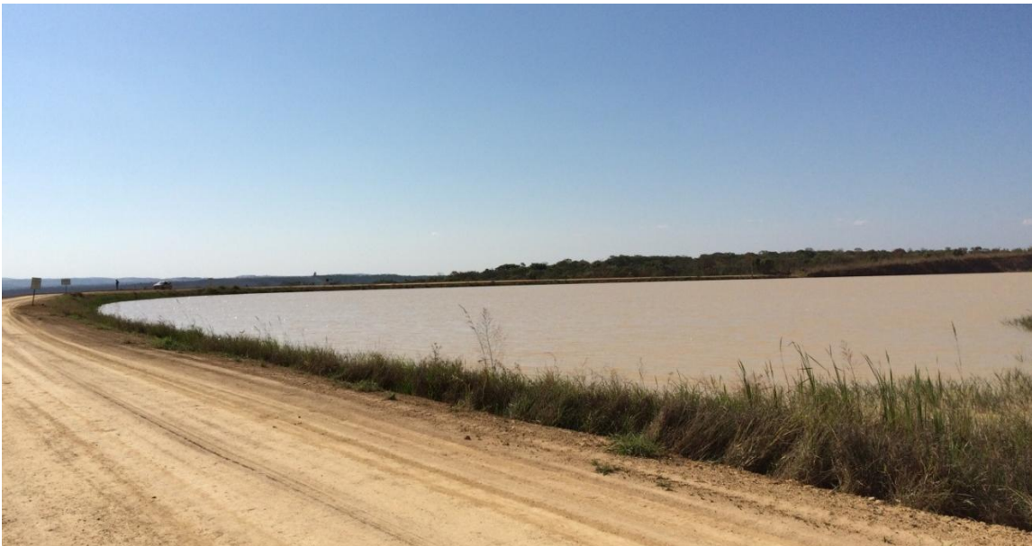
Foto 3.1-4 - Vista parcial da Cava B.
