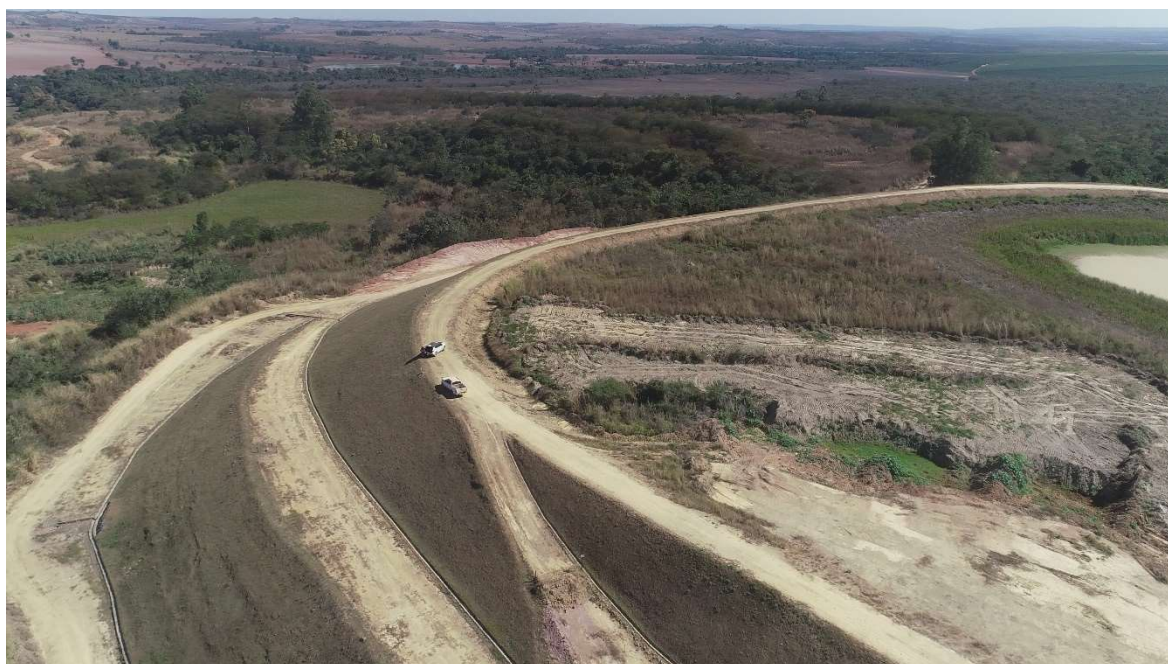
Figura 3: Vista área da Barragem Cava B e região a jusante da estrutura.
