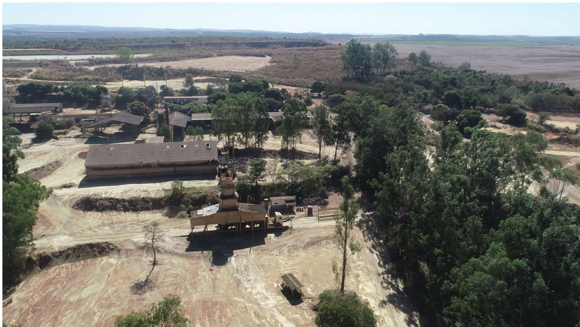
Figura 19: Vista geral do contexto do uso e ocupação do solo na área de influência da Barragem Cava B. Destaque para a área industrial e administrativa concernida fora da mancha de inundação.
