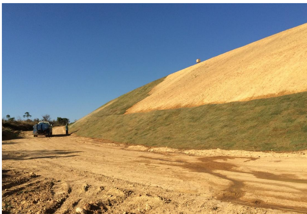
Foto 3.1-6 - Recuperação do talude – plantio de grama.
