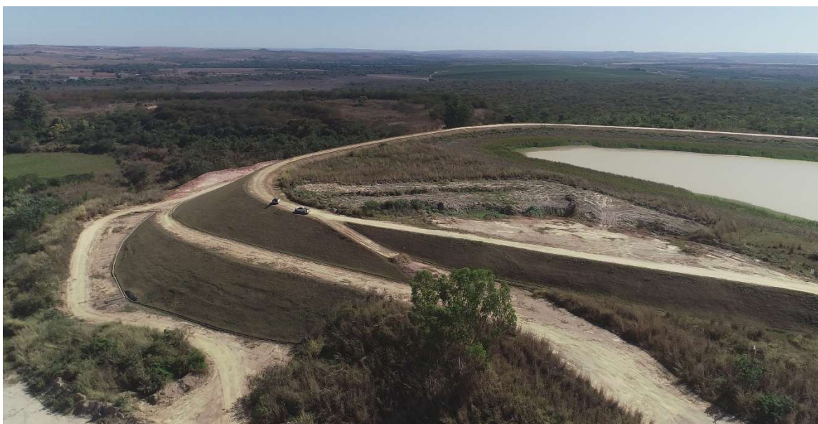
Figura 2: Vista área da Barragem Cava B e região a jusante da estrutura.
