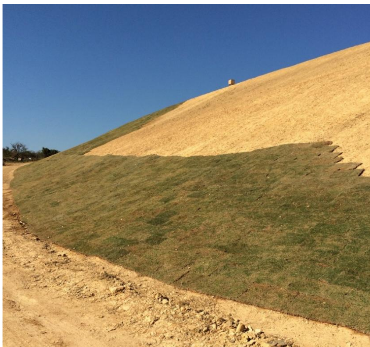
Foto 3.1-5 - Recuperação do talude – plantio de grama.
