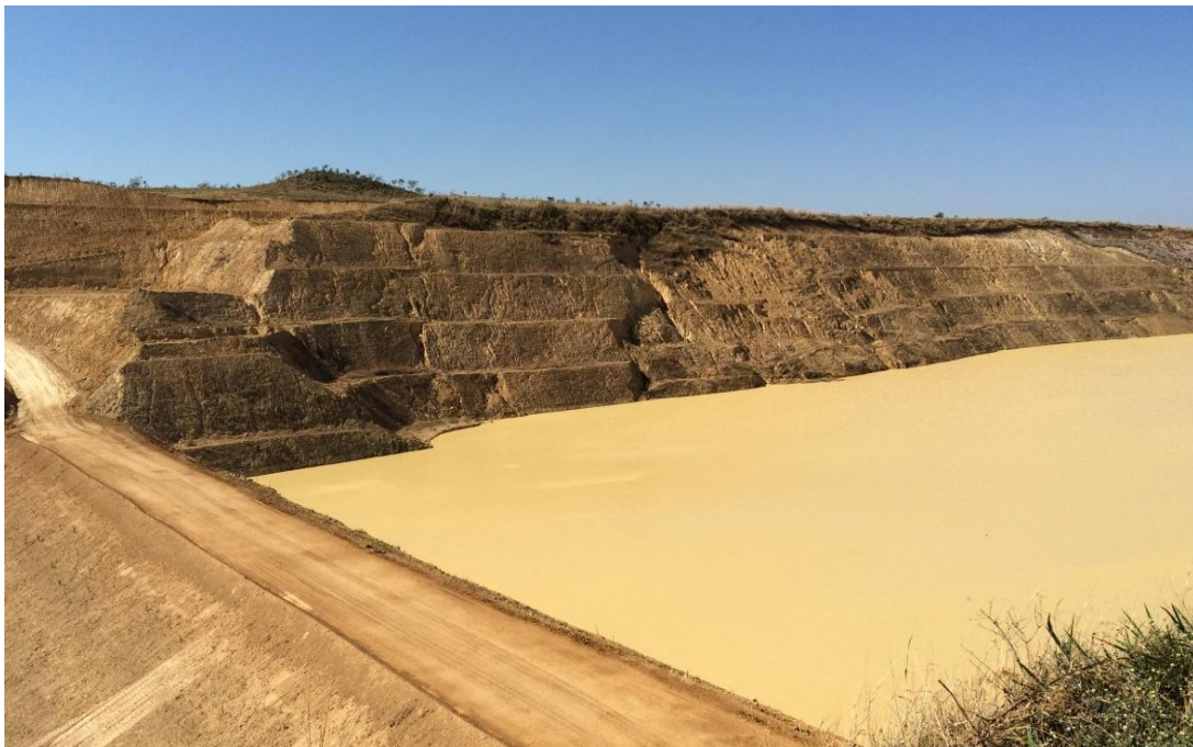
Foto 3.1-10 - Vista da Cava 1 com presença de escorregamento e instabilidade geotécnica.
