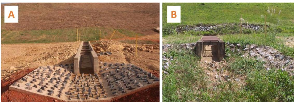
Figura 7 - Sistema de drenagem superficial: A) Construção da bacia de sedimentação. B) Condições atuais da bacia de sedimentação.
