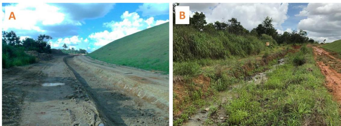
**Figura 4 - Sistema Extravaso: A) Construção do seguimento do canal extravaso. B) Condições atuais do seguimento do canal extravaso.**
