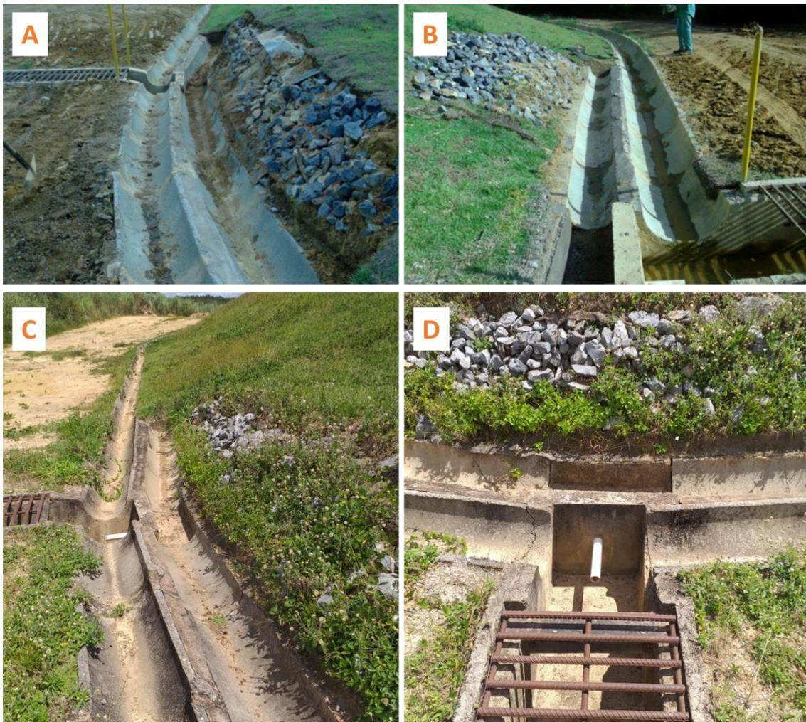
Figura 6 - Sistema de drenagem superficial: A) e B) Construção das saídas dos drens de pé. C) e D) Condições atuais dos drens de pé.
