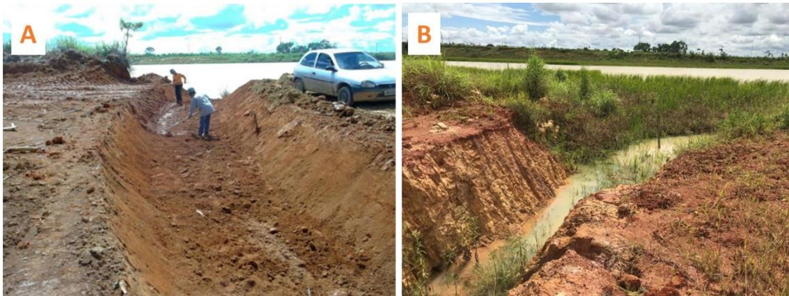
**Figura 3 - Sistema Extravaso: A) Construção da entrada do canal extravaso. B) Condições atuais do canal extravaso.**
