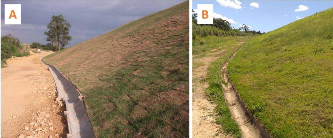
**Figura 8 - Sistema de drenagem superficial: A) Instalação das canaletas meia-cana pré-moldada de concreto. B) Condições atuais das canaletas.**
